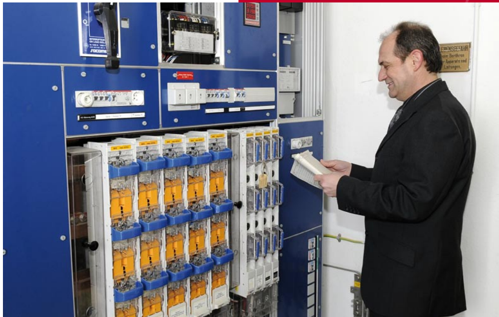
Hans Villiger bei Kontrollarbeiten in der TS Breiten
