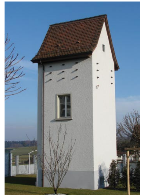
Trafostation Mitteldorf Auw
